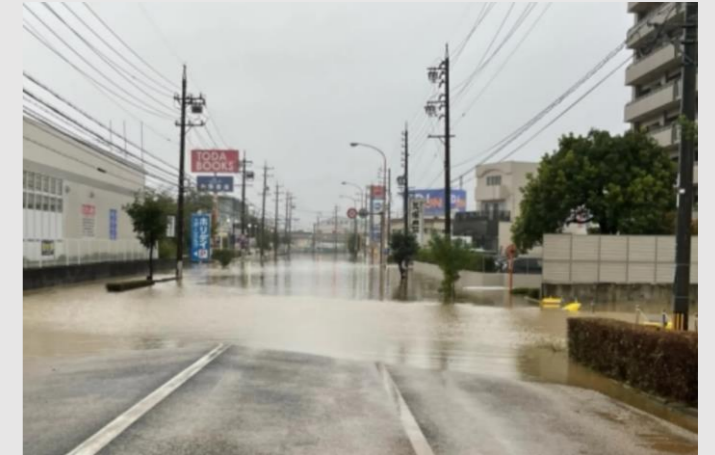
水没した道路 (静岡市水道局ホームページ)
