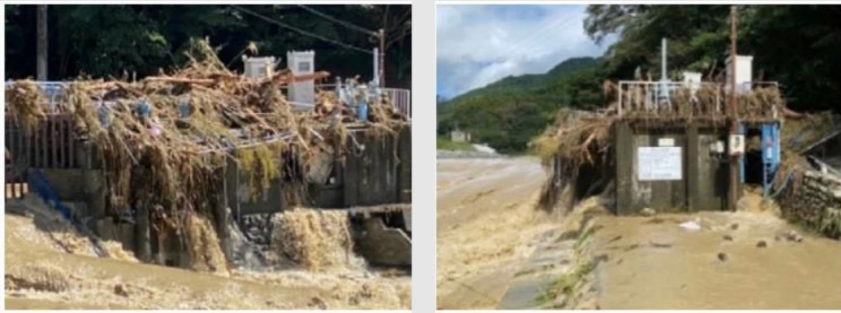
興津川承元寺取水口 (静岡市水道局ホームページ)
